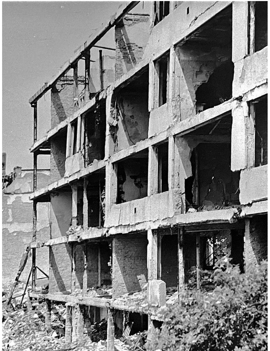
Stahlskelett und Betonplatten nach Luftangriffen deutlich erkennbar, 1946 (Fotoausschnitt: Fred Kochmann, ISG FFM S7Ko, Nr. 1672)
