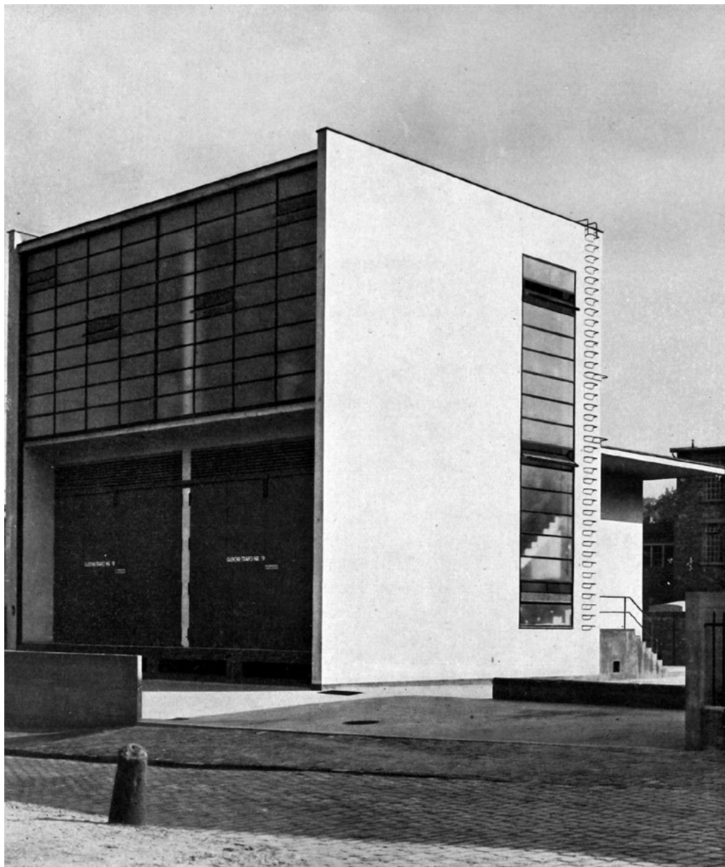
Gleichrichterstation, um 1928 (Foto: Wasmuths Monatshefte für Baukunst, 1931/3)
