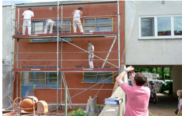
Aufbringen des eingefärbten Deckputzes am 19.5.2009. Foto: Claus Giel
